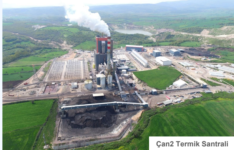
Çan2 Termik Santrali
