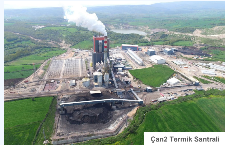
Çan2 Termik Santrali
