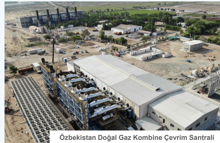
Özbekistan Doğal Gaz Kombine Çevrim Santrali
