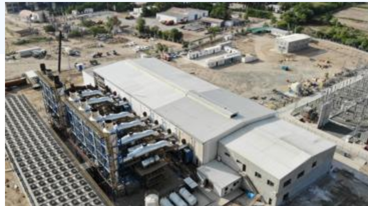
Özbekistan Doğal Gaz Kombine Çevrim Santrali
