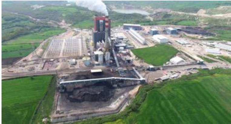
Çan2 Termik Santrali
