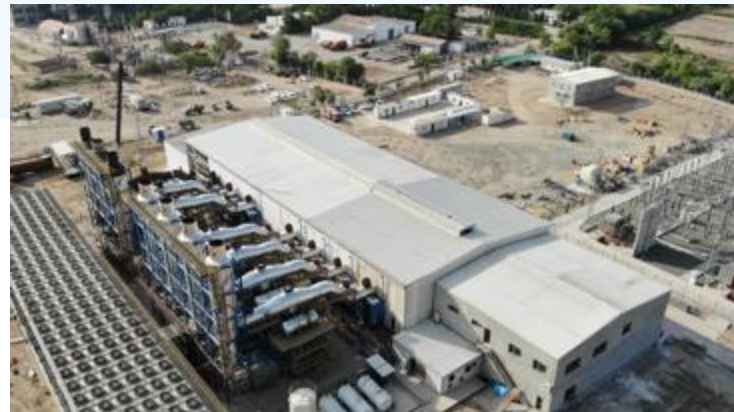
Özbekistan Doğalgaz Kombine Çevrim Santrali
