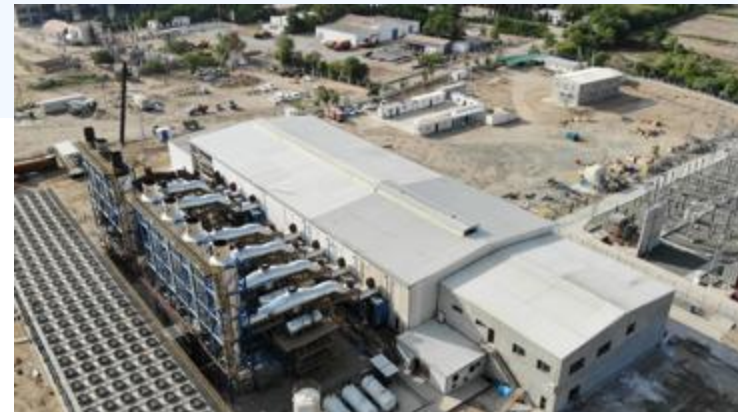
Özbekistan Doğalgaz Kombine Çevrim Santrali
