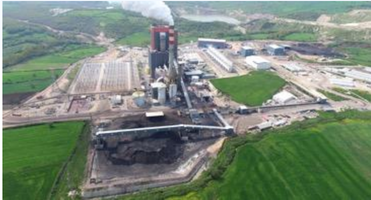
Çan2 Termik Santrali
